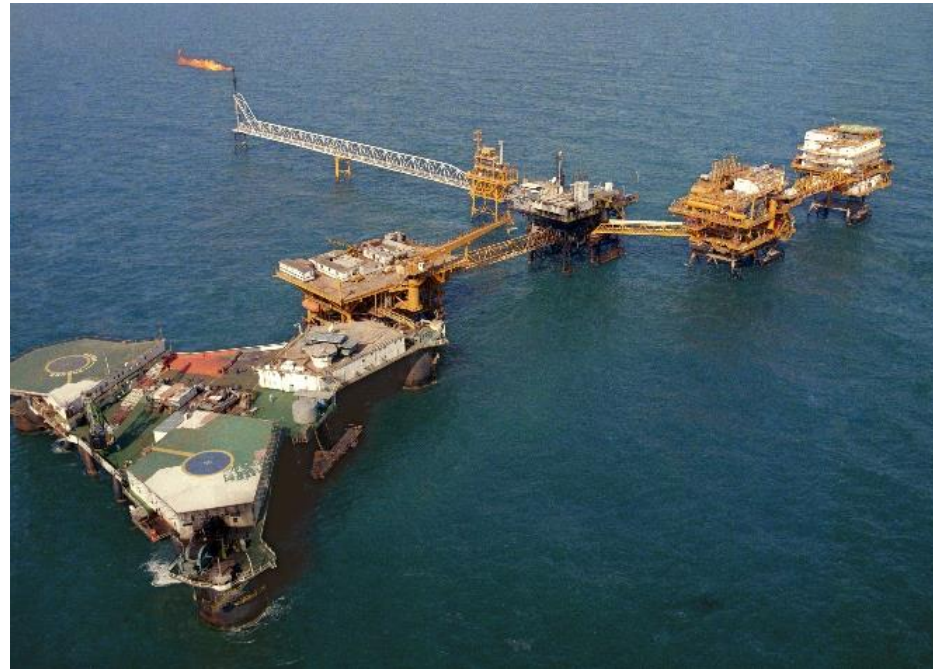
سکوی ابوذر - منطقه خارگ
