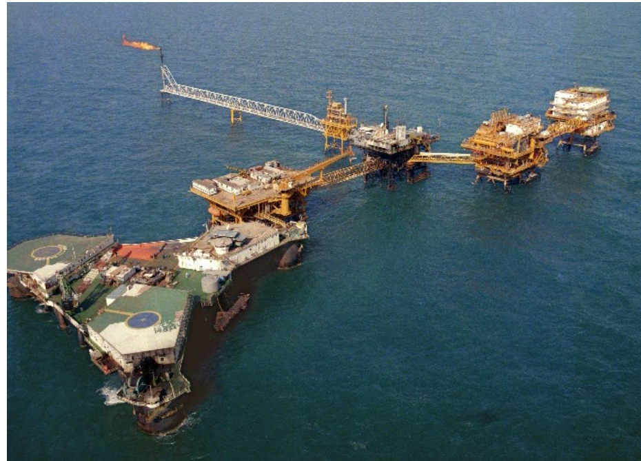
سکوی ابوذر - منطقه خارگ
