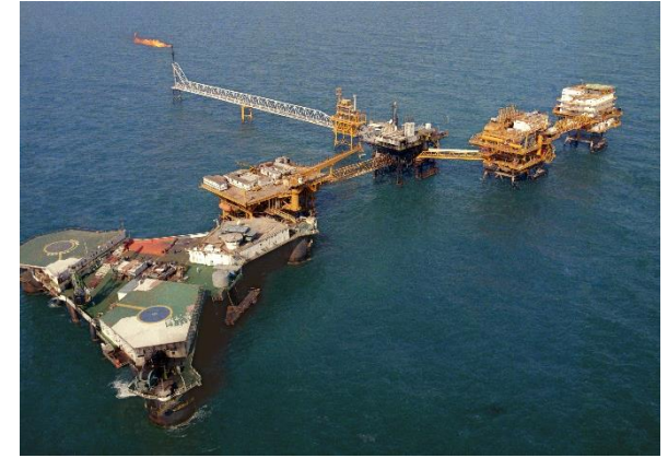
سکوی ابوذر - منطقه خارگ
